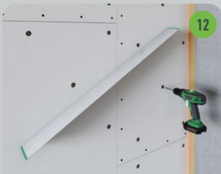
После предварительного крепления панелей по всей поверхности, ориентируясь на линию по периметру, производится финишное выравнивание плоскости панелей строительным правилом путем закручивания саморезов УН 5x90 / 5x120.
