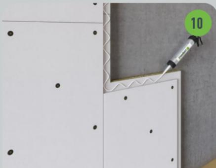
Виброакустический герметик SG наносится на кромку панелей SG Gipslock 30/40/70 в процессе их монтажа.
