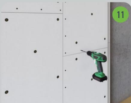
Саморезами ГП 3,9x30 (из комплекта крепежа для панелей SG Gipslock 30/40/70) панели скрепляются между собой по кромке, шаг саморезов на кромке должен быть не более 200 мм.
