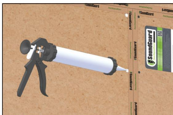
**7** Места стыков и швы примыкания панелей к полу, стенам и потолку заполняются герметиком **SoundGuard Seal**. Стыки панелей заполняются герметиком при помощи шпателя или монтажного пистолета, обязательно не ранее, чем через 24 часа после монтажа. Стыки панелей проклеиваются самоклеющейся лентой **SoundGuard Tape**.
