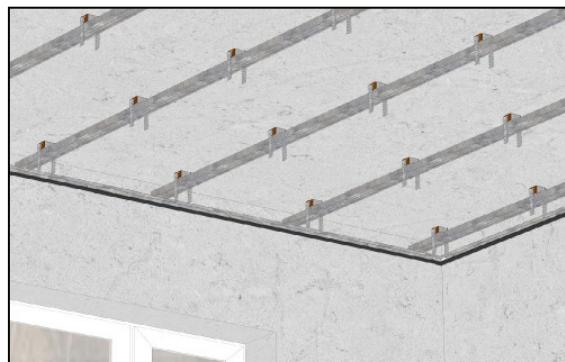
**4** Второй уровень потолочных профилей устанавливается с шагом 400 или 600 мм и крепится к профилям первого уровня с помощью двухуровневого соединителя. Торец потолочного профиля второго уровня проклеивается демпферной лентой **SoundGuard Band Rubber**.
