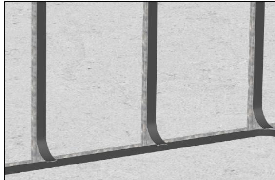
**4** Стоечные профили устанавливаются с шагом 400–600 мм. Внутренняя полость каркаса заполняется звукоизглощающим материалом из линейки **SoundGuard**.
