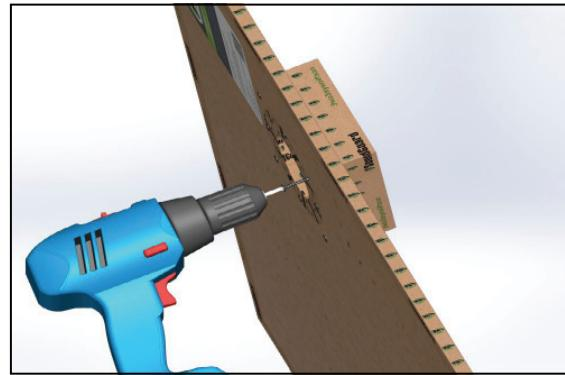
**13** Для точного позиционирования отверстия в листе из гипсоволокна следует по периметру подрозетника нанести небольшое количество герметика **SoundGuard Seal**. Приложив лист из гипсово-локна, мы получим отметку для прорезания отверстия. Место выхода электропровода заполняется герметиком **SoundGuard Seal**.
