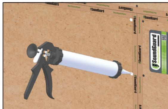
**7** Места стыков панелей между собой и швы примыкания к полу, стенам и потолку при помощи шпателя или монтажного пистолета заполняются герметиком **SoundGuard Seal**, желательно не ранее, чем через 24 часа после монтажа, и проклеиваются самоклеющейся лентой **SoundGuard Tape**.
