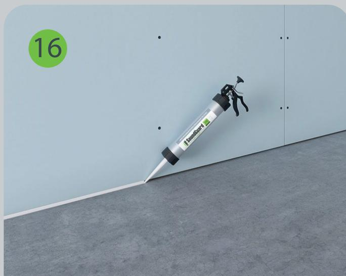
Между торцами листов гипсокартона и поверхностями пола, стен и потолка остается зазор 3 – 5 мм, который заполняется герметиком SoundGuard Seal.
