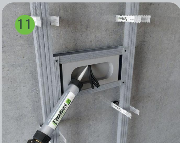
Заводятся провода. Место выхода электропровода промазывается герметиком SoundGuard Seal.
