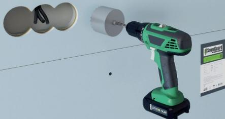
После монтажа звукоизоляционного гипсокартона SoundGuard Gipsoton в нем коронкой просверливается отверстие в месте установки звукоизоляционного подрозетника SoundGuard ИзоБокс Стандарт.
