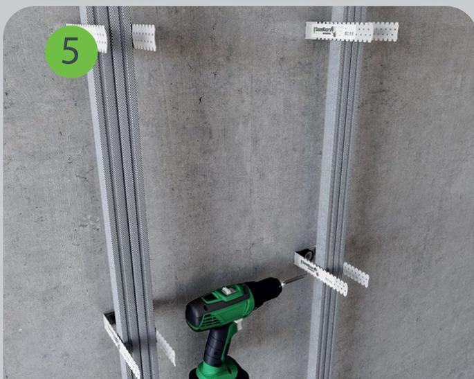
Потолочные профили крепятся к виброизоляционным подвесам саморезами SoundGuard с буром. Шаг профилей составляет 600 мм.
