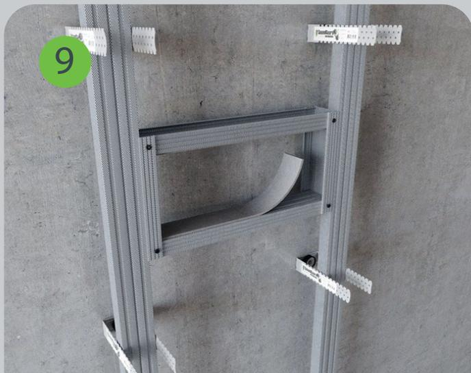
Места установки звукоизоляционного подрозетника SoundGuard ИЗОБокс Стандарт проклеиваются демпферной лентой SoundGuard ВиброЛента.
