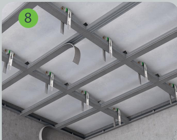
Направляющие и потолочные профили проклеиваются демпферной лентой SoundGuard ВиброЛента.
