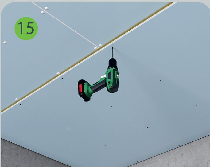
Гипсокартон Gipsophon монтируется совместно с мембраной и крепится к профилю без зазоров между листами саморезами SoundGuard XTN 3,9x41. Расход составляет не менее 17 шт./м<sup>2</sup>. Шляпки саморезов слегка утапливаются.
