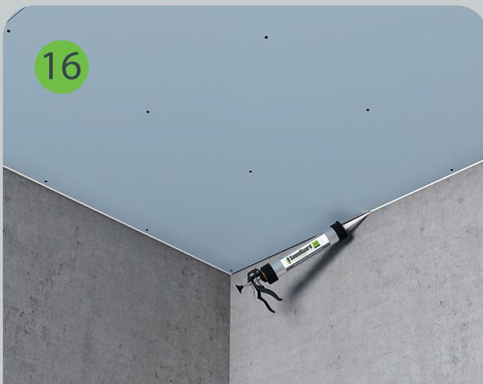
Между торцами листов гипсокартона и поверхностями стен остается зазор 3 – 5 мм, который заполняется герметиком SoundGuard Seal.
