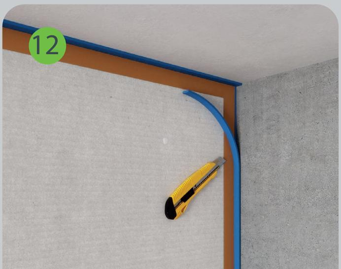
После установки звукоизоляционных панелей SoundGuard Premium излишки звуко-виброизоляционной подложки SoundGuard ВиброСтоп 25 удаляются.
