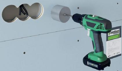
После монтажа звукоизоляционного гипсокартона Gipsofon ПЛУК в нем коронкой просверливается отверстие в месте установки звукоизоляционного подрозетника SoundGuard Изобокс Премиум.
