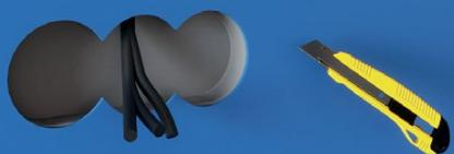
На месте установленного звукоизоляционного подрозетника SoundGuard ИзоБокс Премиум в подложке вырезается отверстие.
