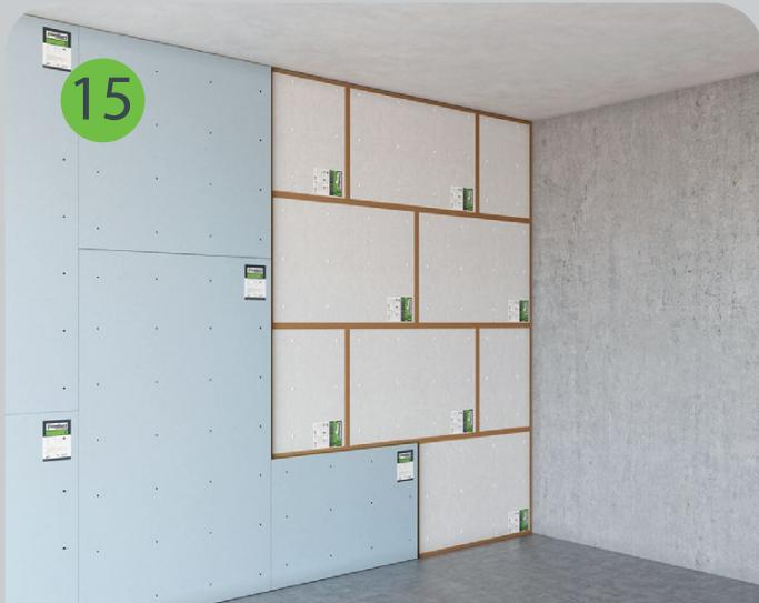
Звукоизоляционный гипсокартон Gipsofon ПЛУК монтируется без зазоров между листами. Расход саморезов SoundGuard ГП 3,9x30 составляет не менее 22 шт./м<sup>2</sup>.
