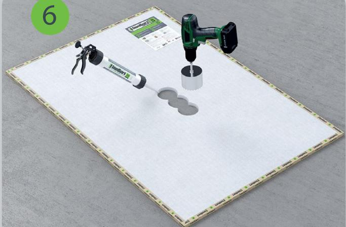
Отверстие под гнездо розетки или выключателя вырезается заранее в горизонтально расположенной панели SoundGuard Premium и промазывается вибравакуистическим герметиком SoundGuard Seal.
