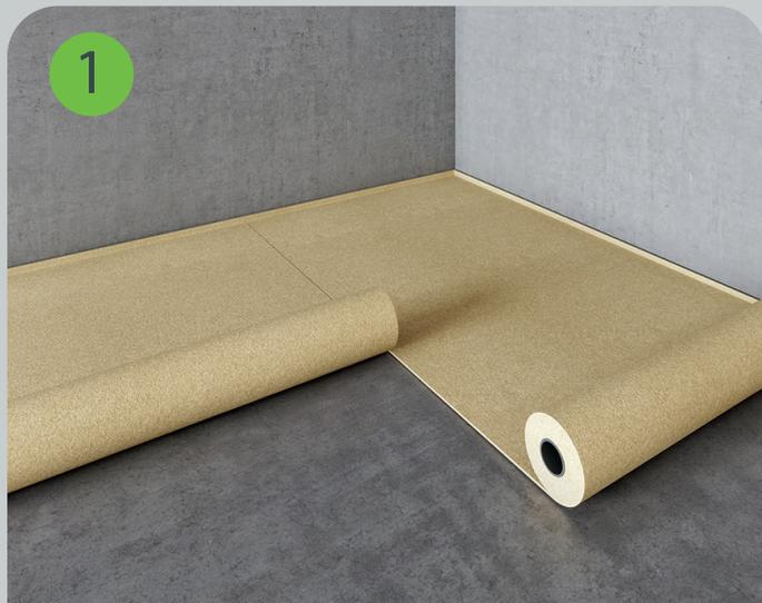
На очищенную поверхность пола укладывается виброакустическая подложка SoundGuard VibroRoll стык в стык с заведением на стены на 10 мм.
