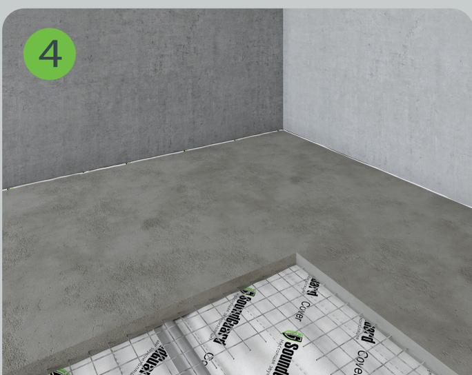
Поверх звукоизоляционного материала выполняется цементно-песчаная или бетонная стяжка толщиной минимум 60 мм. Стяжка должна быть армирована сеткой в 1/3 ближе к низу слоя.
