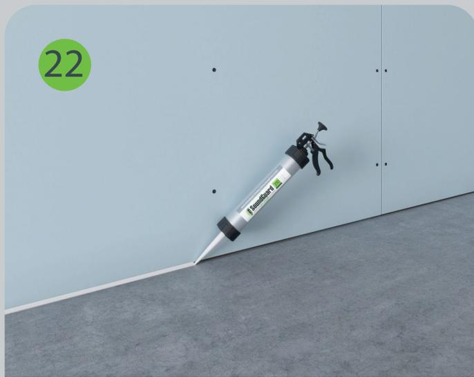
Между торцами листов гипсокартона и поверхностями пола, стен и потолка остается зазор 3 – 5 мм, который заполняется виброакустическим герметиком SoundGuard 310.
