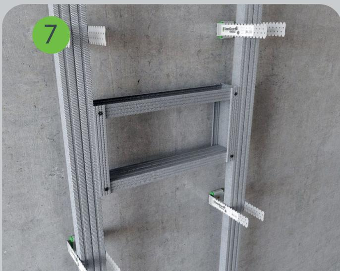
Устанавливаются дополнительные металлические профили в местах установки розеток и выключателей.
