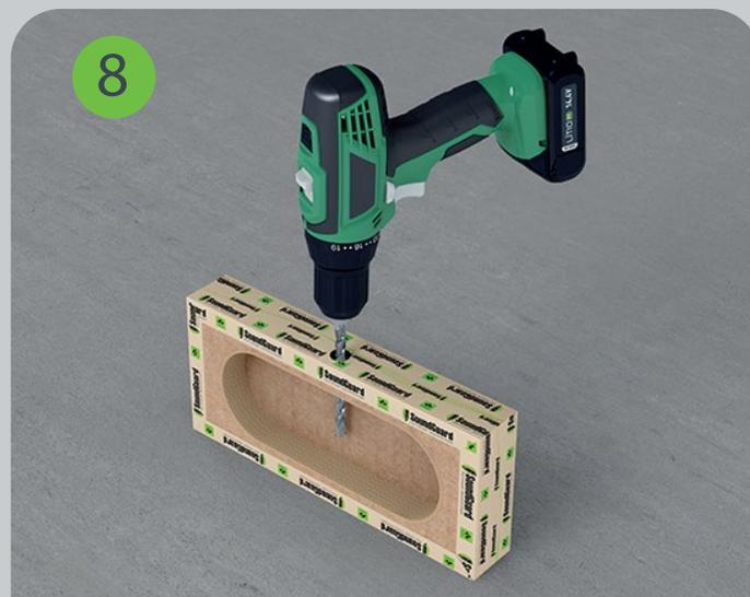
В звукоизоляционной подрозетнике SoundGuard ИзоБокс Премиум просверливается отверстие для выпуска проводов.
