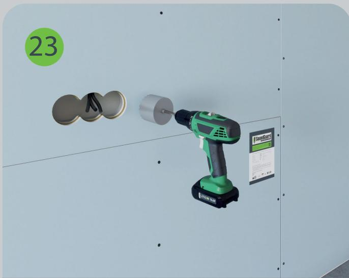
После монтажа звукоизоляционного гипсокартона Gipsophon ПЛУК в нем коронкой просверливается отверстие в месте установки звукоизоляционного подрозетника SoundGuard ИзоБокс Премиум.
