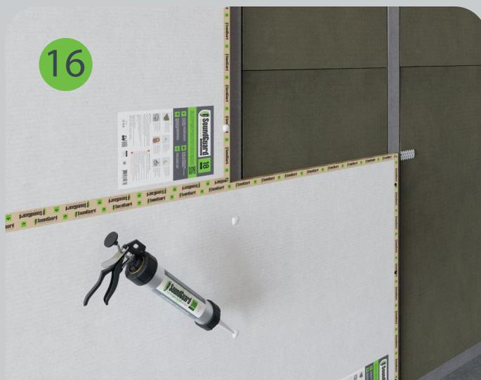
Шляпки саморезов слегка утапливаются и промазываются виброакустическим герметиком SoundGuard 310.
