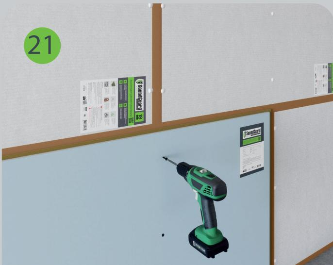
Звукоизоляционный гипсокартон Gipsophon ПЛУК монтируется совместно с мембраной и крепится к профилю без зазоров между листами саморезами SoundGuard XTN 3,9x41. Расход составляет не менее 17 шт./м<sup>2</sup>. Шляпки саморезов слегка утапливаются.
