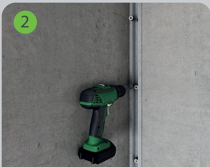
Направляющий профиль крепится через виброкомпенсирующие шайбы SoundGuard ВиброШайба 10x19 с шагом 600 мм с помощью дюбелей SoundGuard DR 6x60 и саморезов SoundGuard УН 4x80\* через просверленные отверстия в профиле.
