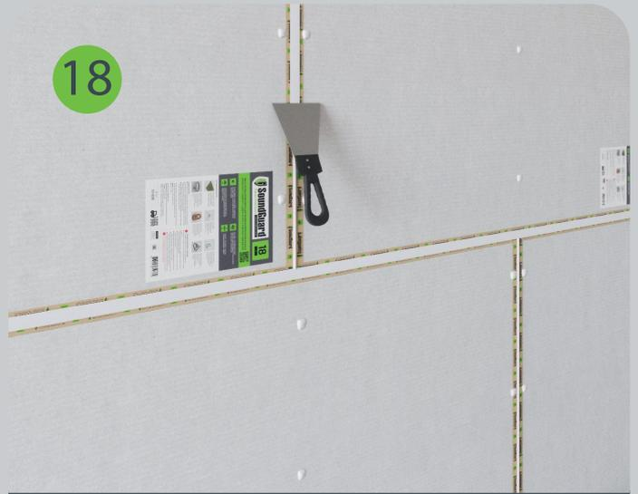
После установки всех панелей герметиком промазываются все швы между панелями и места установки саморезов при помощи шпателя.
