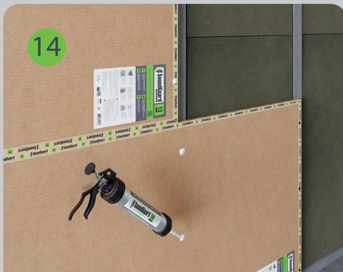
Шляпки саморезов слегка утапливаются и промазываются герметиком SoundGuard Seal.
