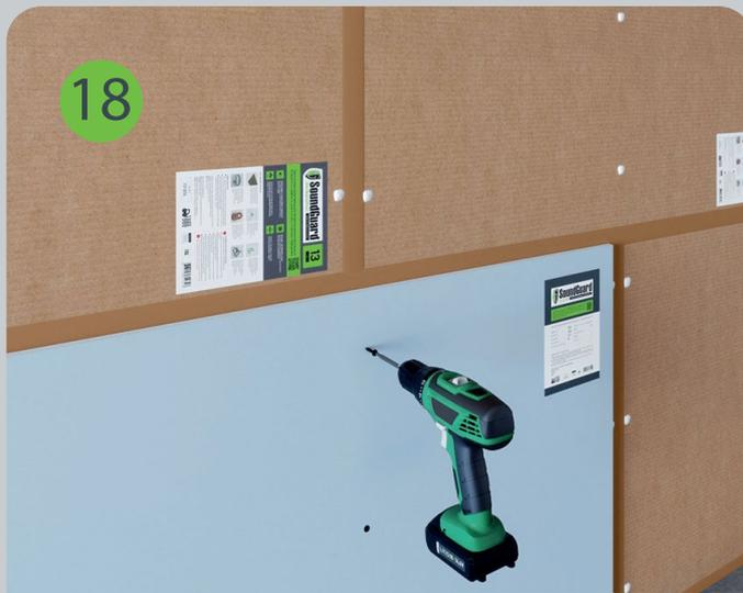
Звукоизоляционный гипсокартон SoundGuard Gipsofon монтируется без зазоров между листами и крепится к профилю саморезами SoundGuard XTN 3,9x41. Расход саморезов составляет не менее 17 шт./м<sup>2</sup> на одну сторону перегородки.
