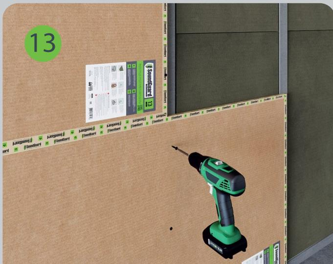
Звукоизоляционные панели SoundGuard ЭкоЗвукоИзол устанавливаются вразбегку и крепятся к профилю саморезами SoundGuard ГМ 3,5x32. На одну звукоизоляционную панель требуется не менее 12 саморезов.
