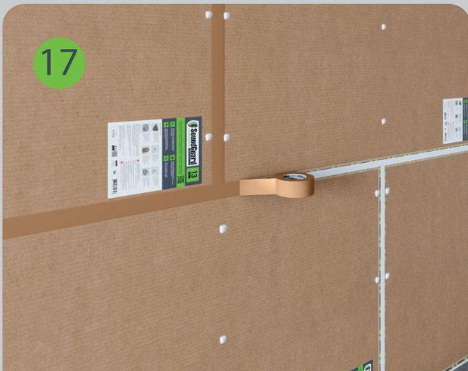
Швы между звукоизоляционными панелями проклеиваются клейкой лентой SoundGuard Tape.
