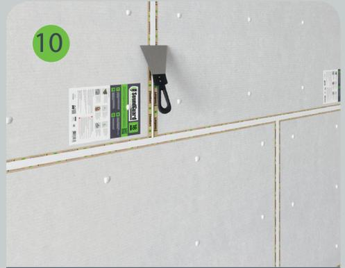
После установки всех панелей, герметиком при помощи шпателя промазываются все швы между панелями и места установки дюбель-гвоздей SoundGuard DA-P.
