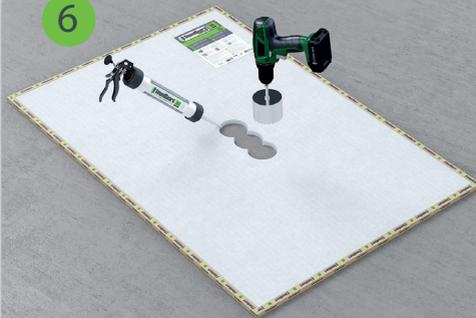
Отверстие под гнездо розетки или выключателя вырезается заранее в горизонтально расположенной панели SoundGuard Premium и промазывается виброакустическим герметиком SoundGuard Seal.
