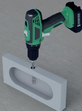
В подрозетнике SoundGuard ИзоБокс Стандарт просверливается отверстие для выпуска проводов. Место выхода электропровода заполняется герметиком SoundGuard Seal.
