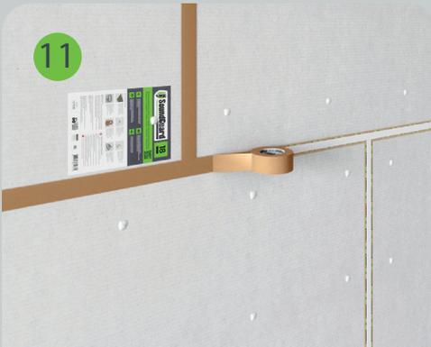
Швы между звукоизоляционными панелями дополнительно проклеиваются клейкой лентой SoundGuard Tape.
