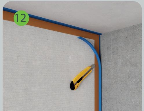
После установки звукоизоляционных панелей SoundGuard Premium излишки демпферной подложки SoundGuard ВиброСтоп 25 удаляются.
