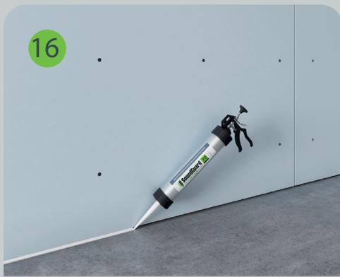
Между торцами листов гипсокартона и поверхностями пола, стен и потолка остается зазор 3 – 5 мм, который впоследствии заполняется герметиком SoundGuard Seal.
