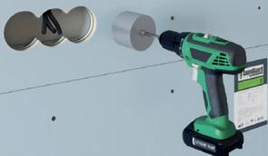
После монтажа звукоизоляционного гипсокартона SoundGuard Gipsolon в нем коронкой просверливается отверстие в месте установки подрозетника.
