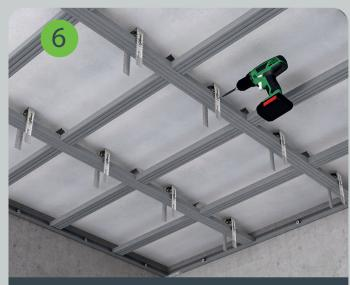
Потолочные профили SoundGuard Strong ПП 60/27 крепятся к виброизоляционным подвесам. Шаг профилей составляет 600 мм в одном направлении и 400 мм — в перпендикулярном. Ячейки каркаса должны иметь размеры  $400 \times 600$  мм.
