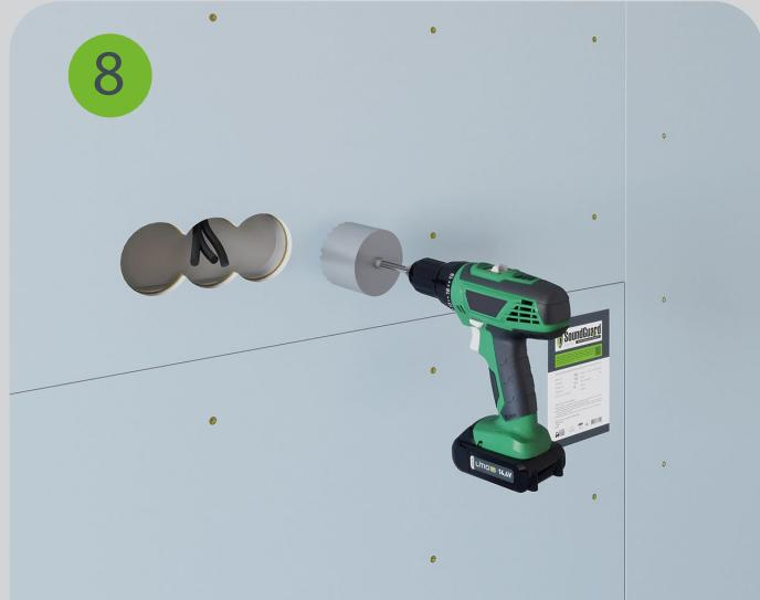
После монтажа звукоизоляционного гипсокартона в нем коронкой просверливается отверстие на месте установки звукоизоляционного подрозетника SoundGuard ИзоБокс Стандарт. Электрический подрозетник прикручивается к внутренней плоскости короба саморезами.
