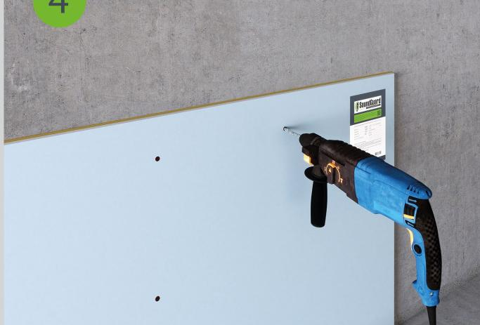
Крепление звукоизоляционного гипсокартона к стене осуществляется универсальными саморезами SoundGuard УН 4x80 с дюбелями SoundGuard DR 6x60 с предварительным засверливанием.
