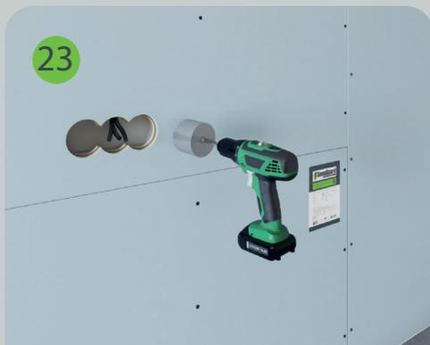
После монтажа звукоизоляционного гипсокартона SoundGuard Gірsofoп в нем коронкой просверливается отверстие в месте установки подрозетника.
