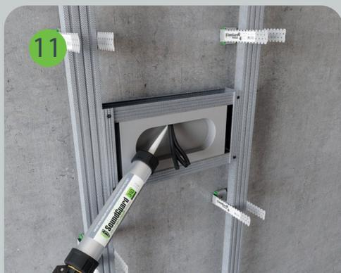
Заводятся провода. Место выхода электропровода промазывается герметиком SoundGuard Seal.
