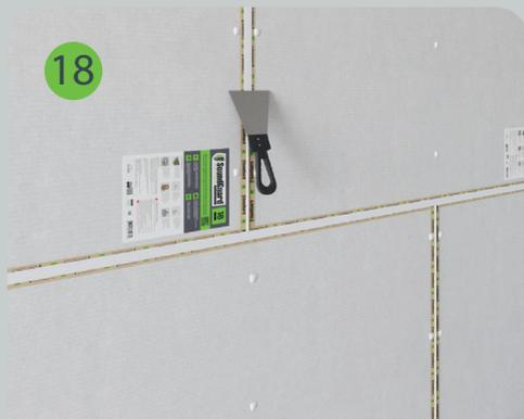
После установки всех панелей, герметиком промазываются все швы между панелями и места установки саморезов при помощи шпателя.
