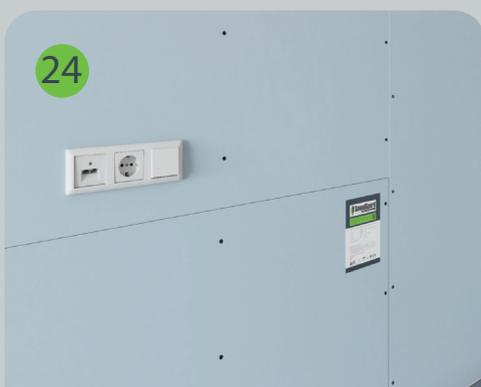
В звукоизоляционный короб SoundGuard монтируется подрозетник, который прикручивается саморезами к внутренней плоскости короба.
