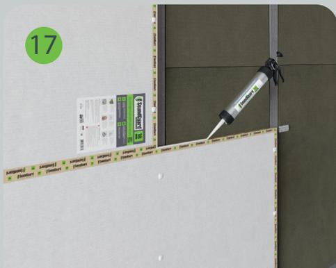
Виброакустический герметик SoundGuard Seal наносится на грани панелей в процессе их монтаж.
