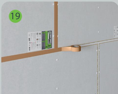
Швы между звукоизоляционными панелями проклеиваются клейкой лентой SoundGuard Tape.
