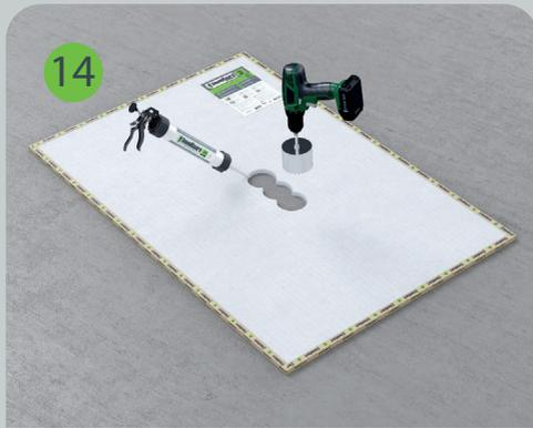
Отверстие под гнездо розетки или выключателя в теле панели вырезается заранее в горизонтально расположенной панели SoundGuard Premium и промазывается виброакустическим герметиком SoundGuard Seal.
