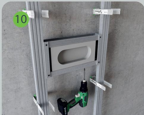
Подрозетник устанавливается в подготовленный каркас и фиксируется саморезами.
