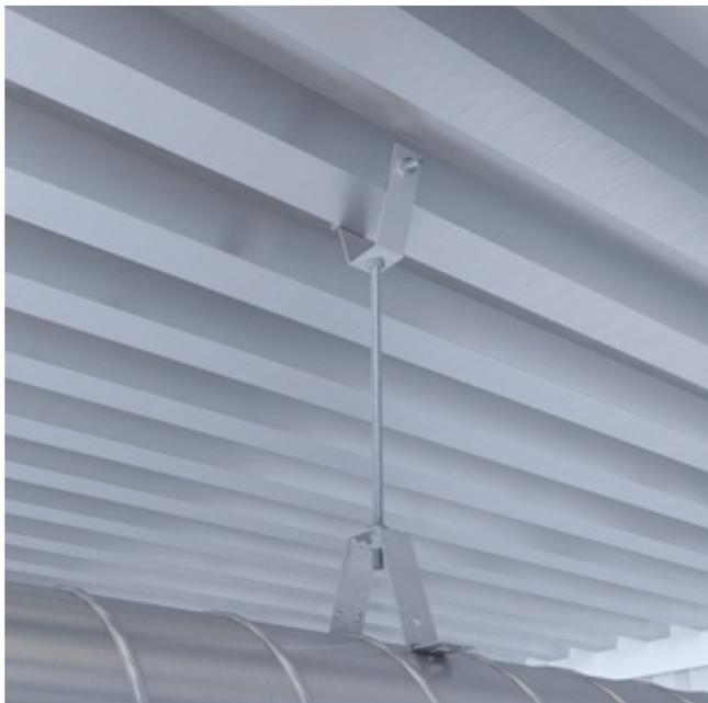
Крепление вентиляционной трубы к потолку с помощью виброизоляционного крепления SoundGuard Креп Про 8
